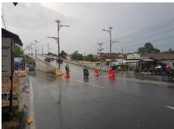
Gambar 1. Kondisi Flyover Teuku Cik Ditiro
